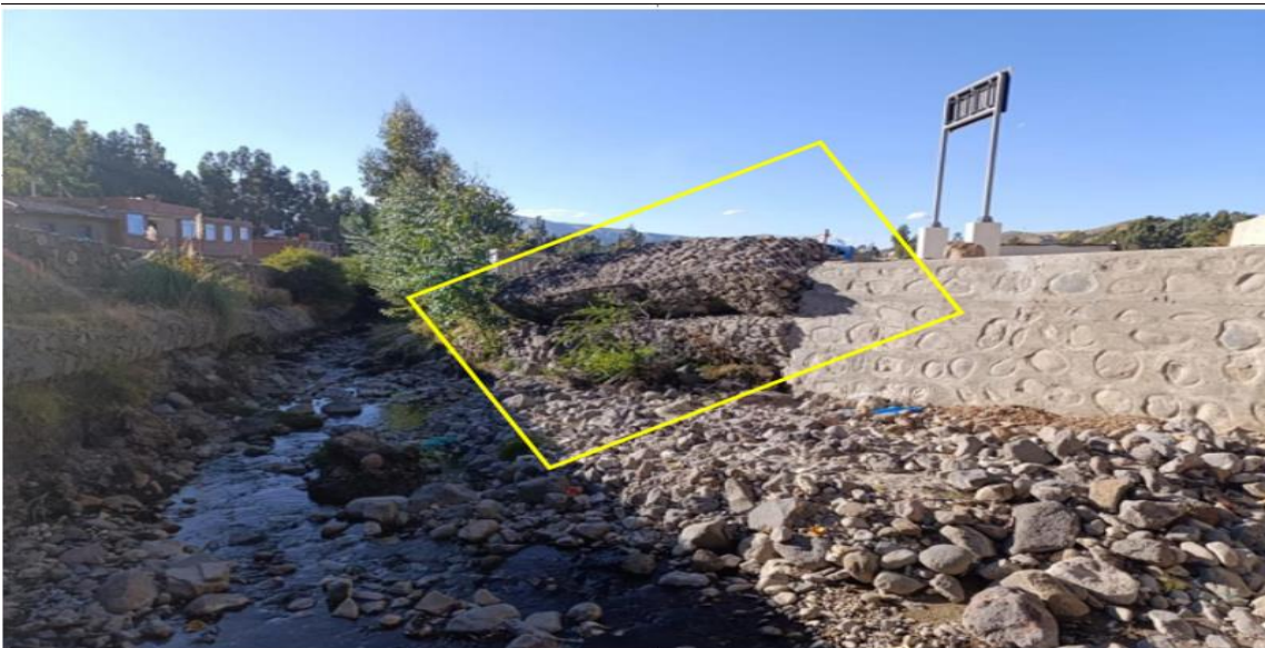
FIGURA N°03: MUROS DE GAVIONES COLAPSADOS AGUAS ABAJO DEL PUENTE PERCCAPAMPA, LO CUAL OCASIONA DESBORDAMIENTO EN LA MARGEN IZQUIERDA PERJUDICANDO VIVIENDAS
