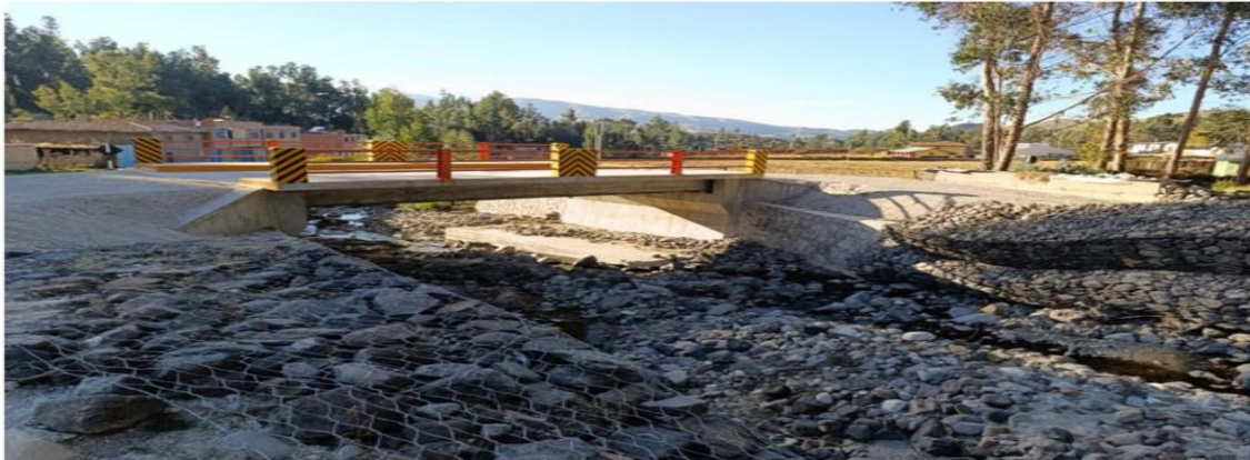
FIGURA N°02: MUROS DE GAVIONES COLAPSADOS TANTO EN LA MARGEN DERECHA E IZQUIERDA DEL RIO PACCHIS, SE OBSERVA INFRAESTRUCTURA EXISTENTE DEL PUENTE PERCCAPAMPA.
