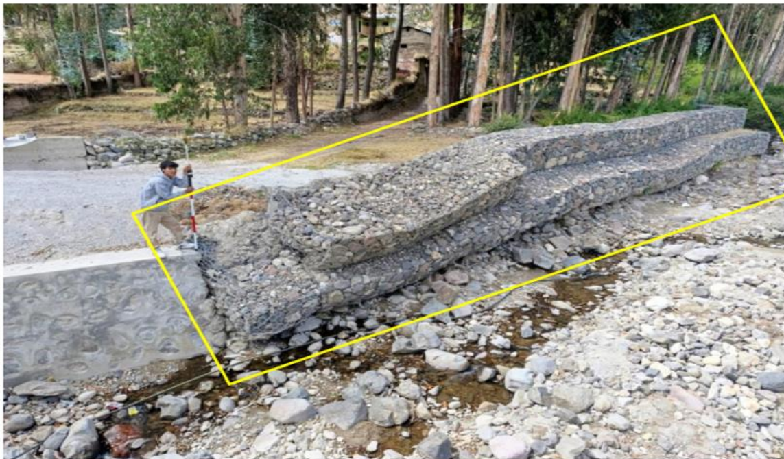
FIGURA N°01: SE OBSERVA MUROS DE GAVIONES COLAPSADOS ANTE LA CRECIDA DEL RIO PACCHIS, ASI COMO TAMBIEN MENCIONAR QUE LA ESTRUCTURA YA HA CUMPLIDO SU TIEMPO DE VIDA UTIL, LO CUAL HA GENERADO DESBORDES EN EPOCAS DE MAXIMAS AVENIDAS AFECTANDO LA PLAZA PRINCIPAL, CARRETERA PRINCIPAL.
